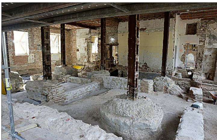
El interior del palacete, actualmente, en obras. E. M.
